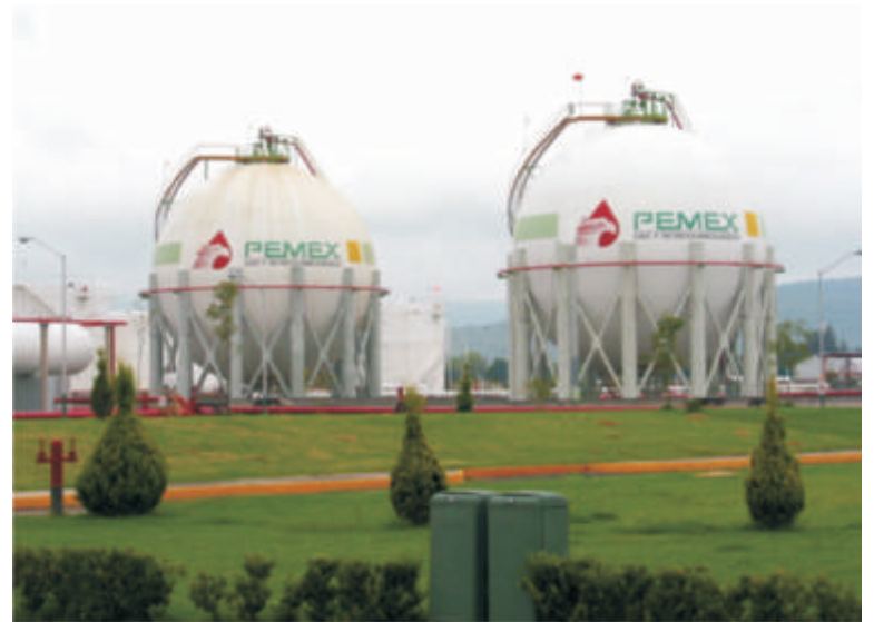
Instalações da PEMEX
